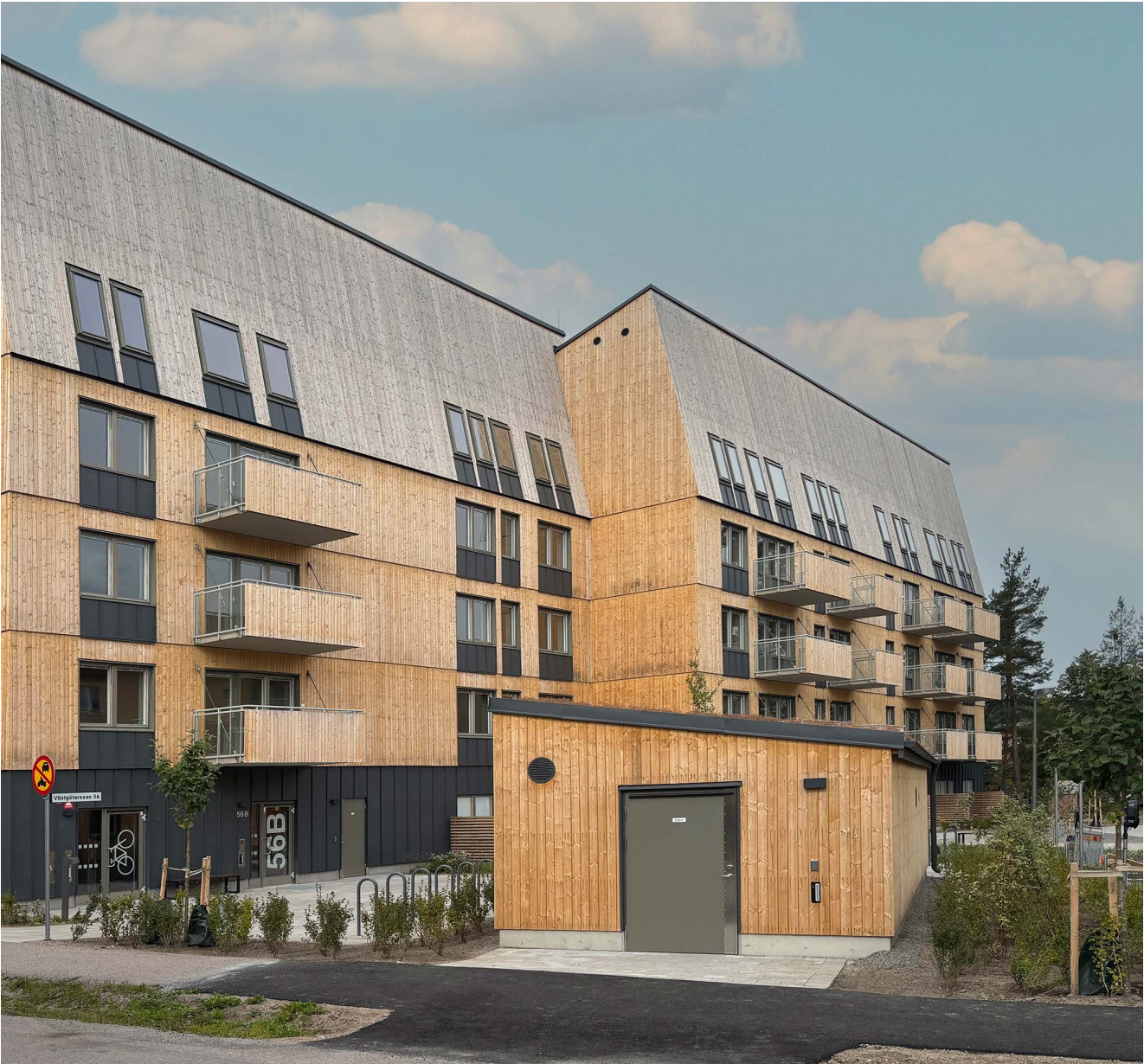
Skandia Fastigheters trähus i Sävja i Uppsala är NollCO 2 -certifierat.
